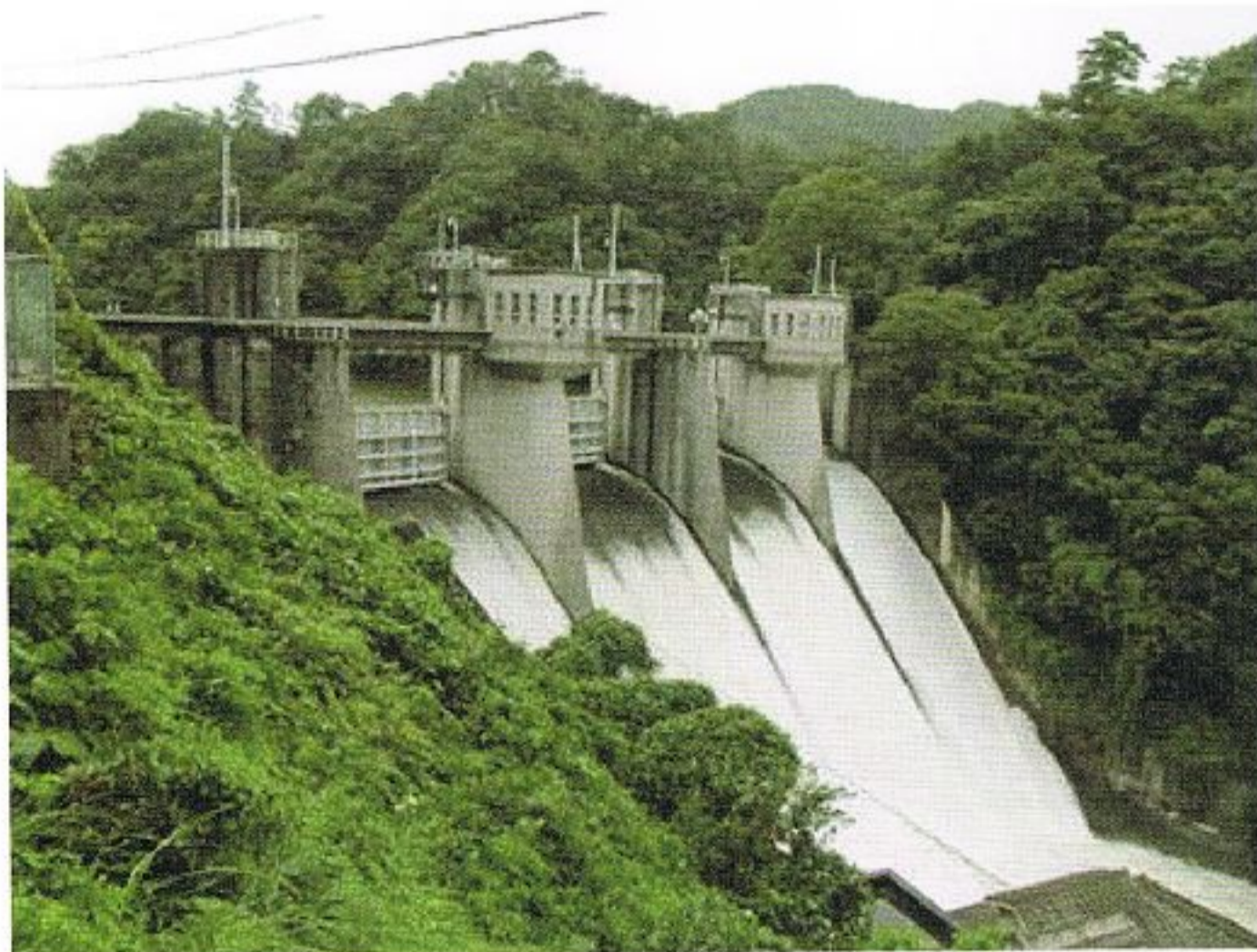
写真 1.1-3 向道ダム(著者撮影)
