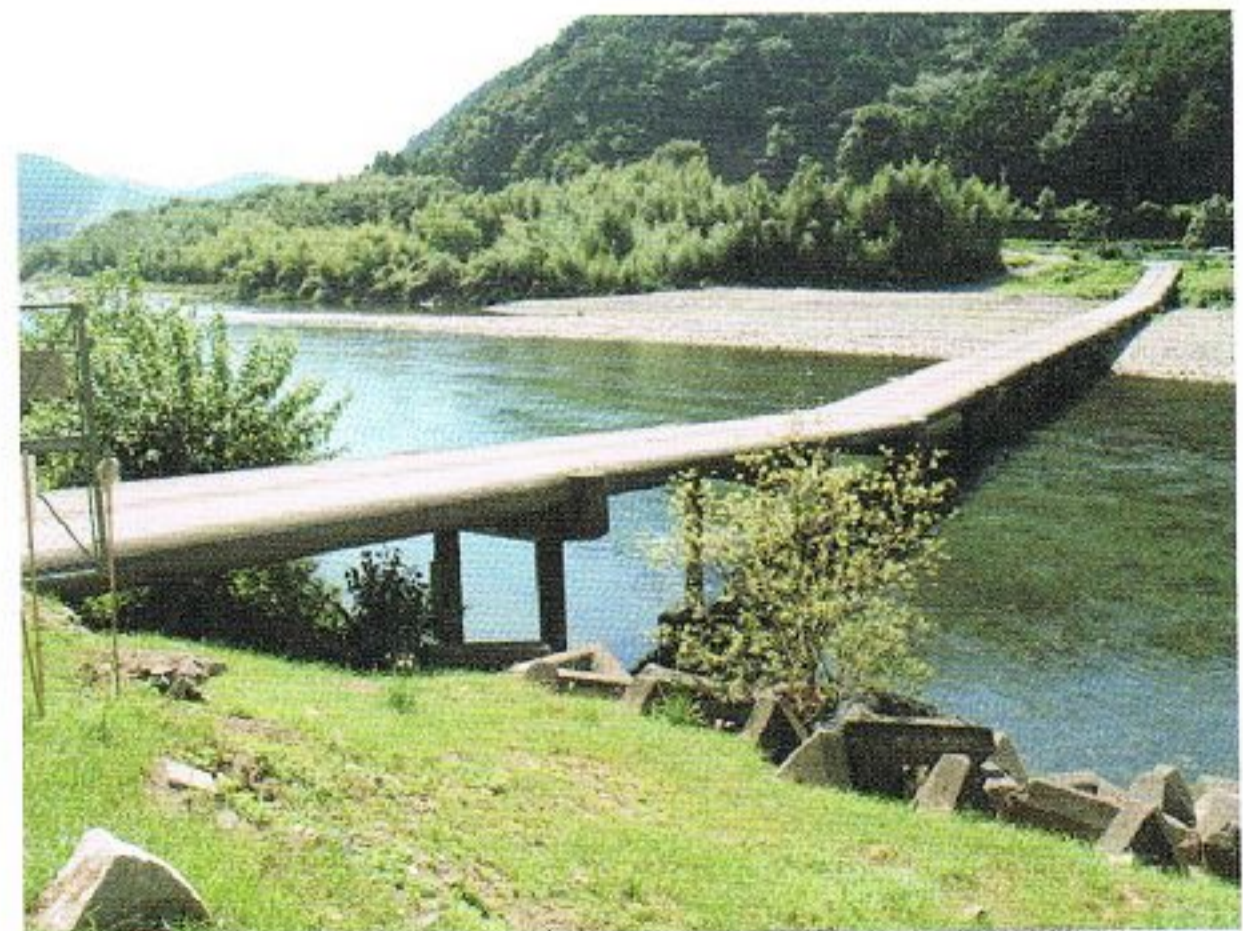
写真 1.1-14 守内の潜水橋(岩国市撮影)
