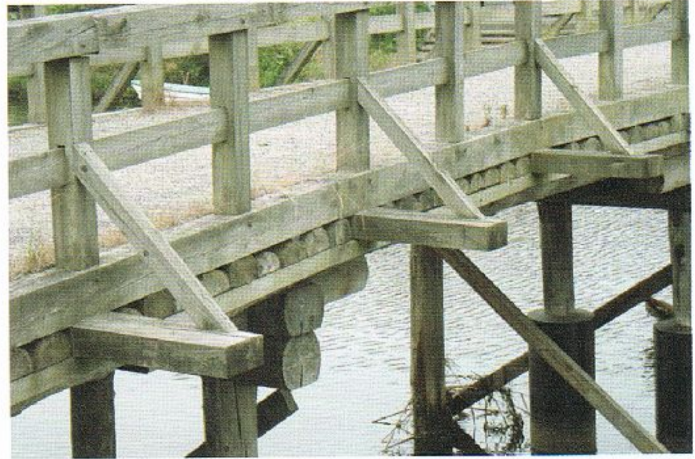
写真 5.3-2 現存する土橋の桁と床版(島根県) (著者撮影)
