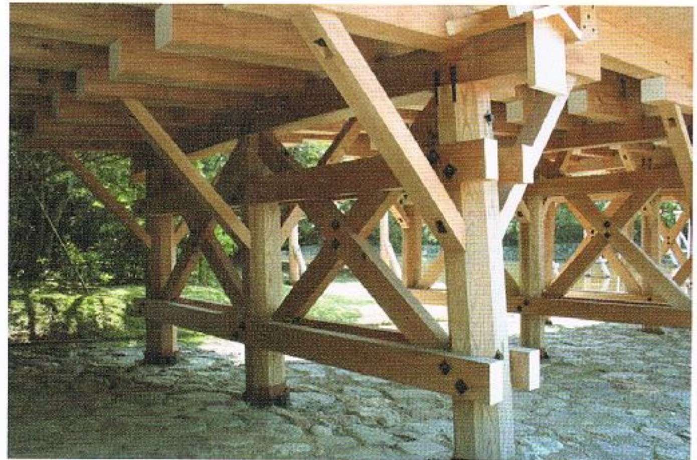
写真 5.3-12 宇治橋の橋脚と桁構造(著者撮影)
