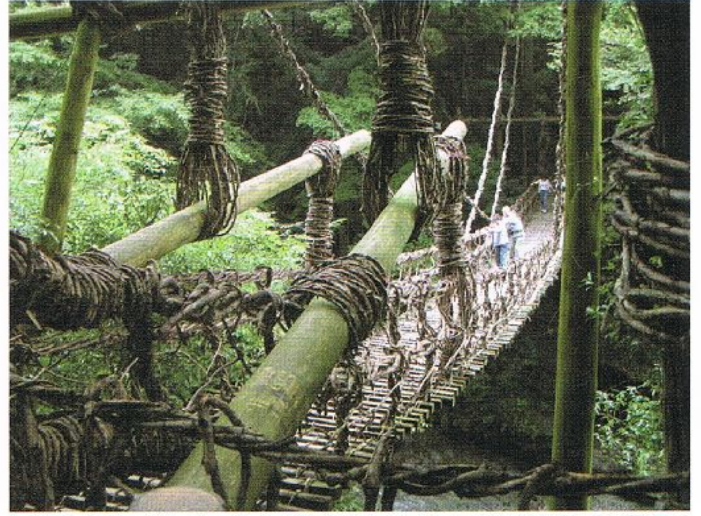
写真 5.3-10 かずら橋の吊り材と路面(著者撮影)
