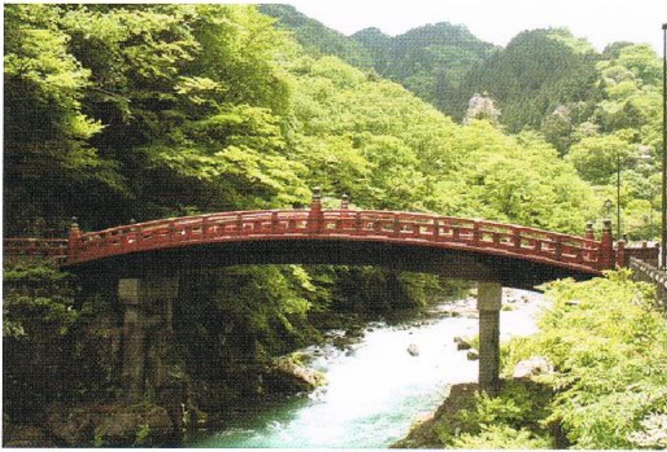
写真 5.3-7 日光の神橋（栃木県，著者撮影）
