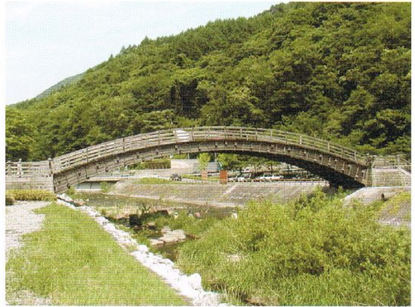
写真 5.3-18 木曾の大橋（長野県，著者撮影）
