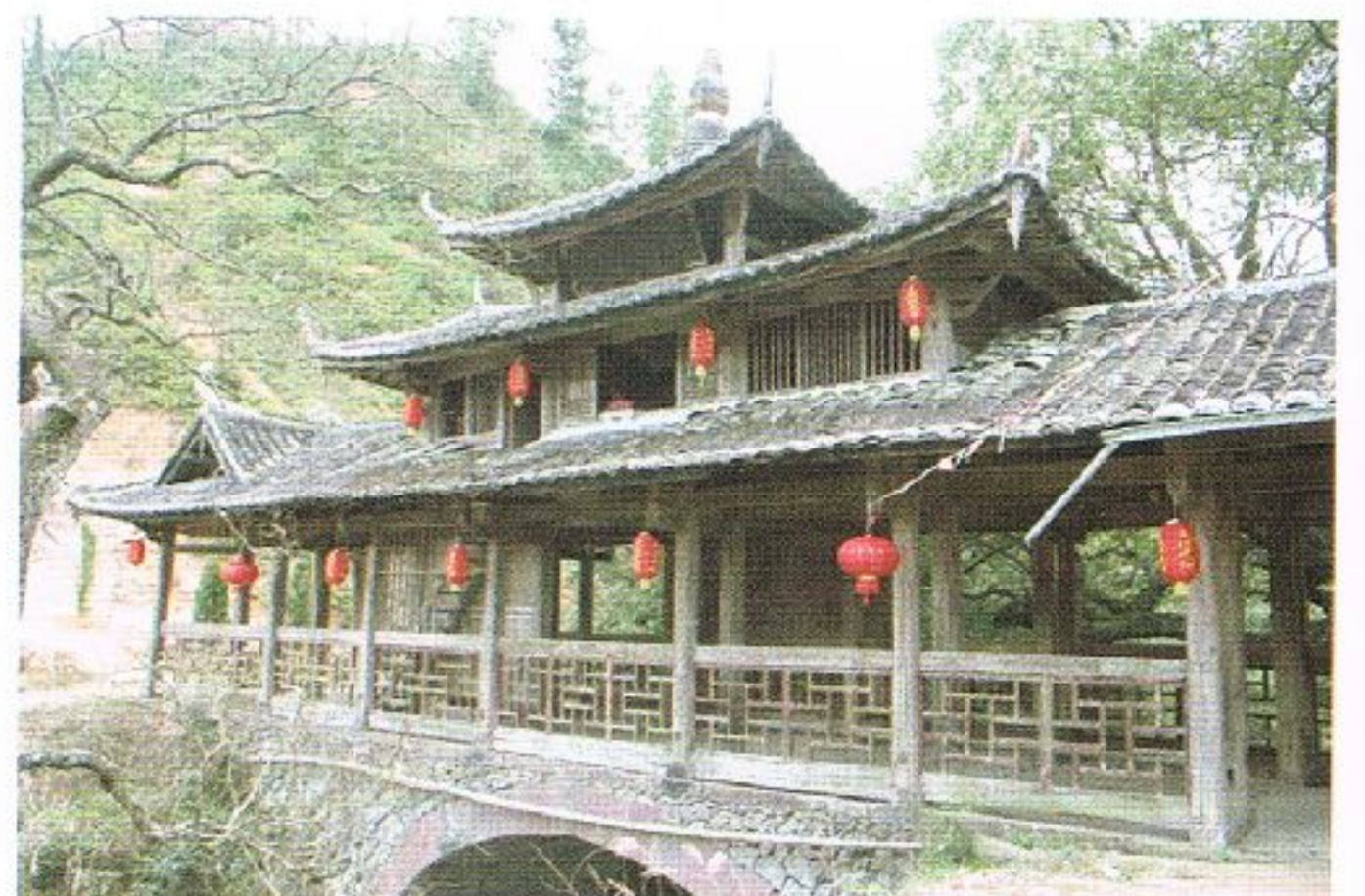
写真 5.2-23 毓文橋の屋根組み(著者撮影)
