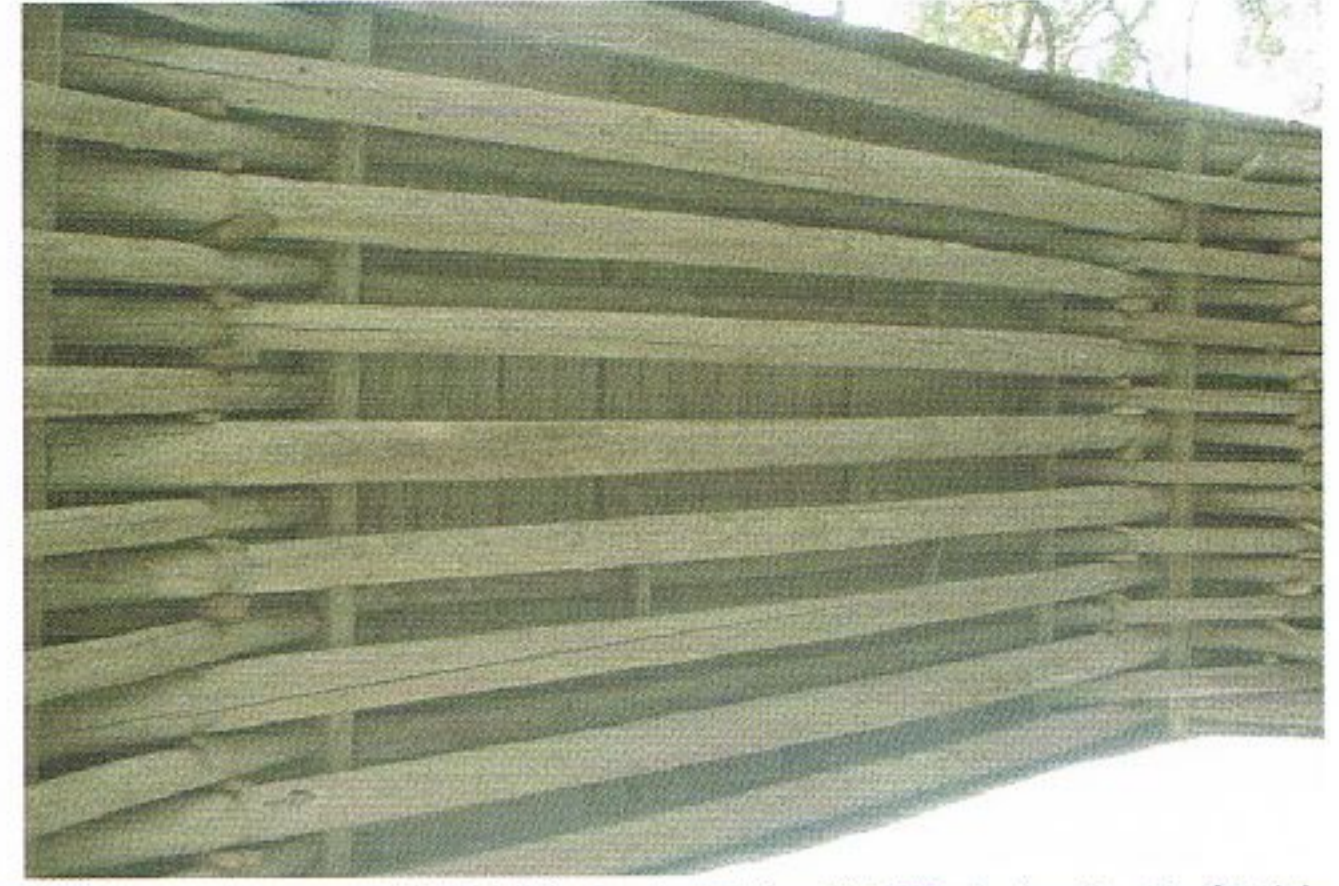
写真 5.2-25 北潤橋の交互に配置された主部材 (著者撮影)
