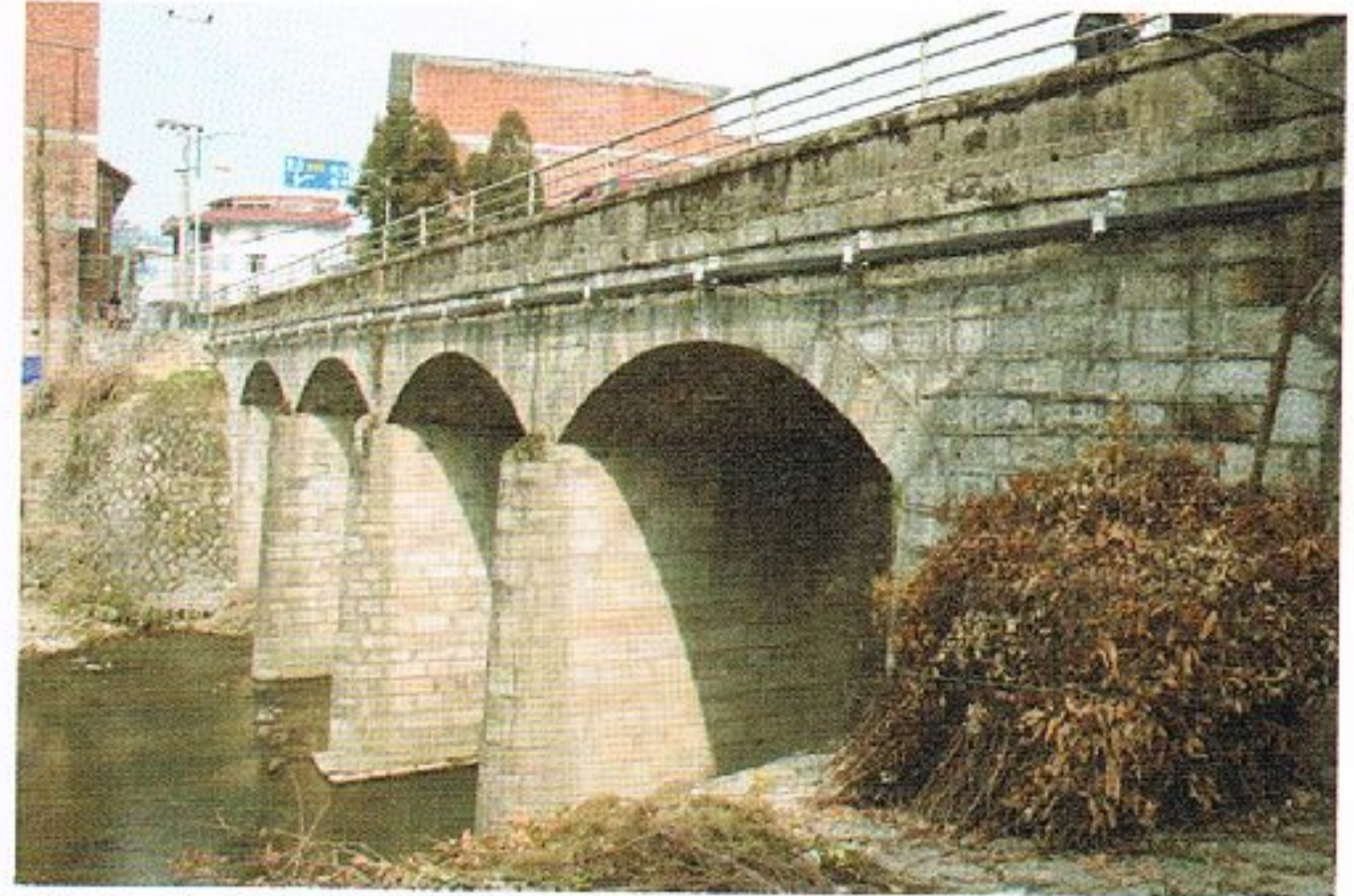
写真 5.2-15 北潤橋に平行する車道橋(著者撮影)
