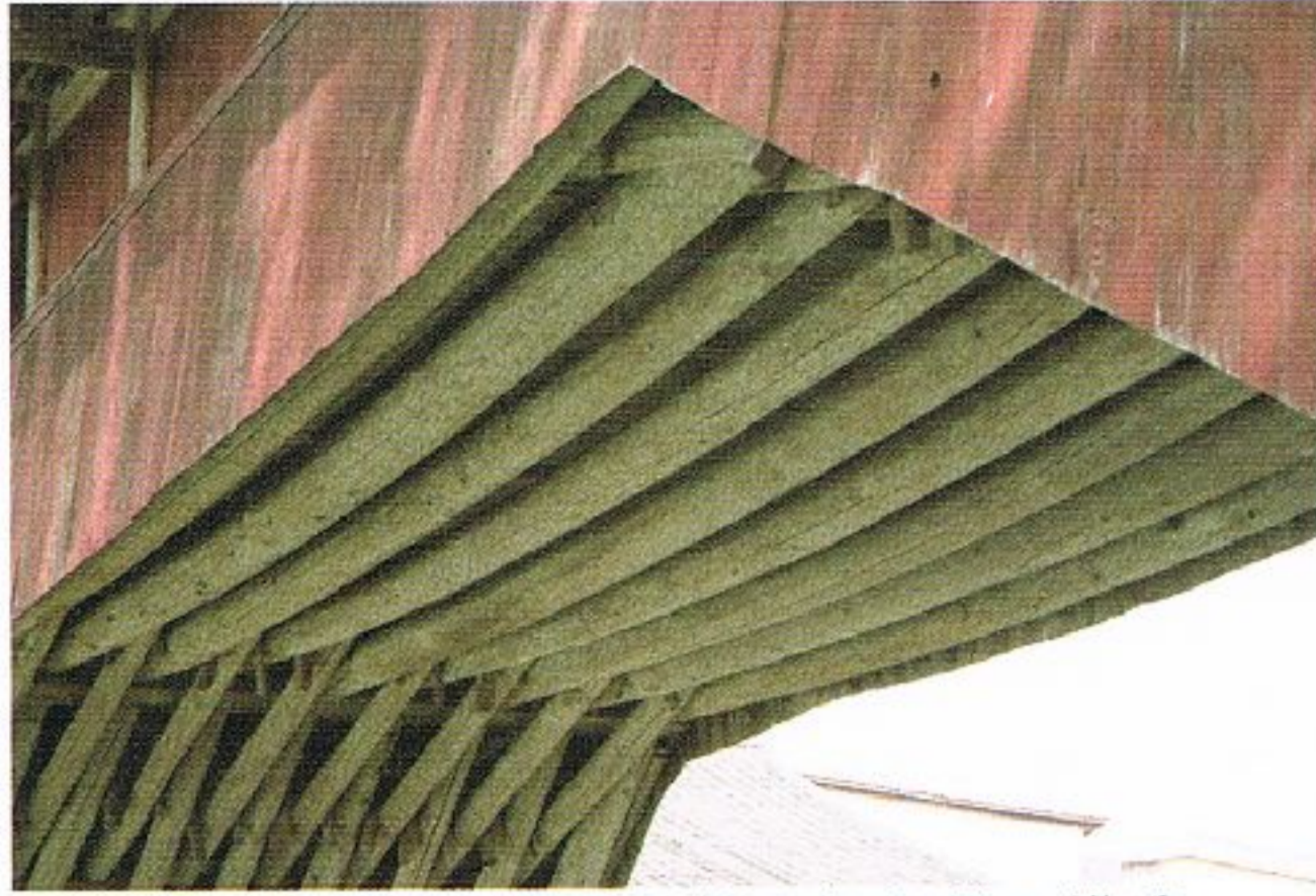
写真 5.2-24 北潤橋の主部材の構造 (著者撮影)
