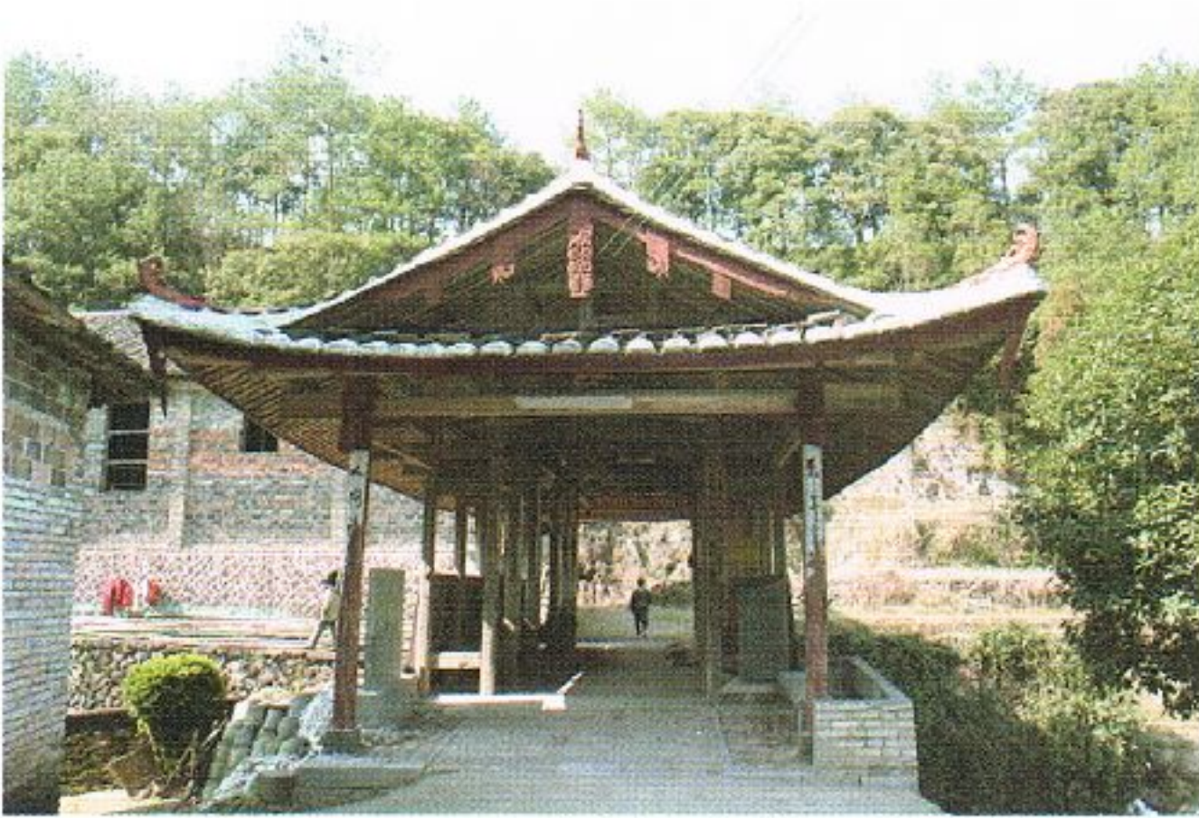
写真 5.2-4 南慶橋の橋詰(著者撮影)
