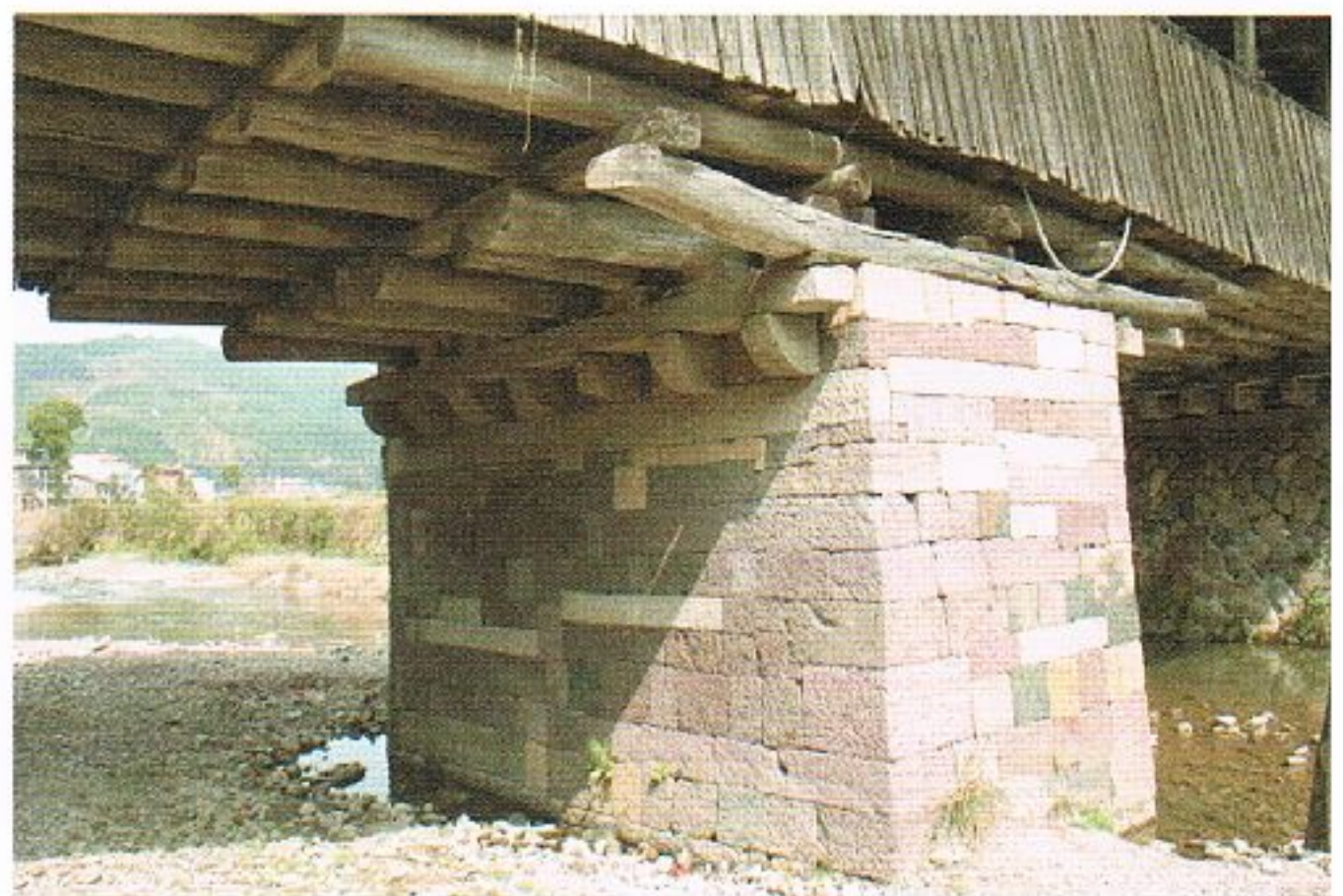
写真 5.2-7 永慶橋の橋脚(著者撮影)
