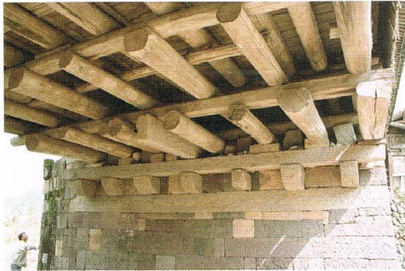
写真 5.2-8 永慶橋の桁構造(著者撮影)
