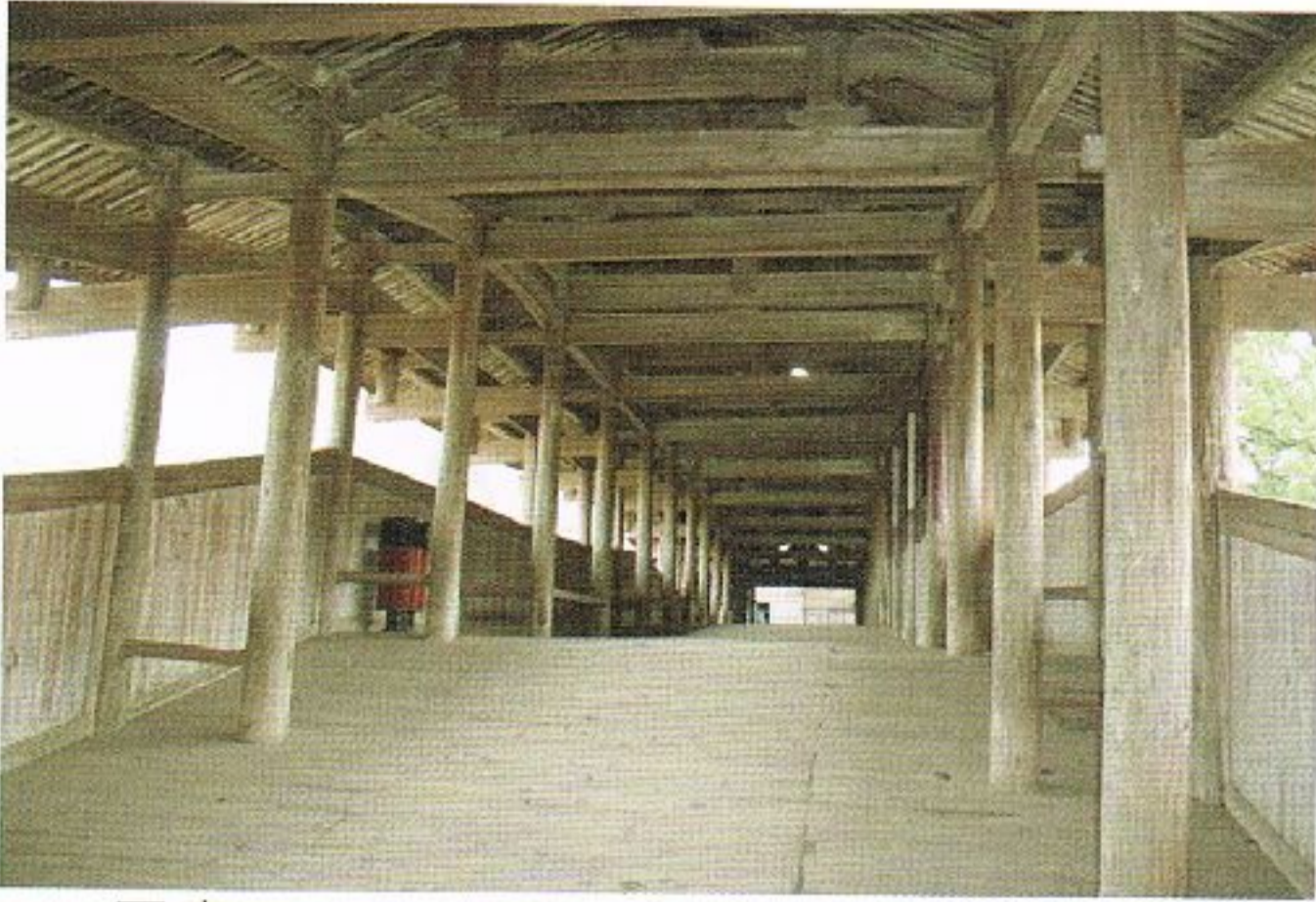
写真 5.2-14 北潤橋の路面(著者撮影)
