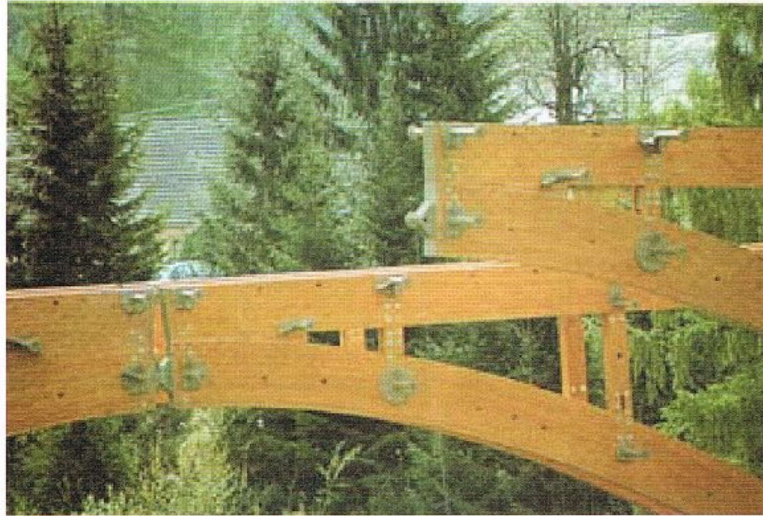
写真 5.1.2-11 アーチトップのピン接合(ムール橋) (Firma Hubert Kulmer 提供)
