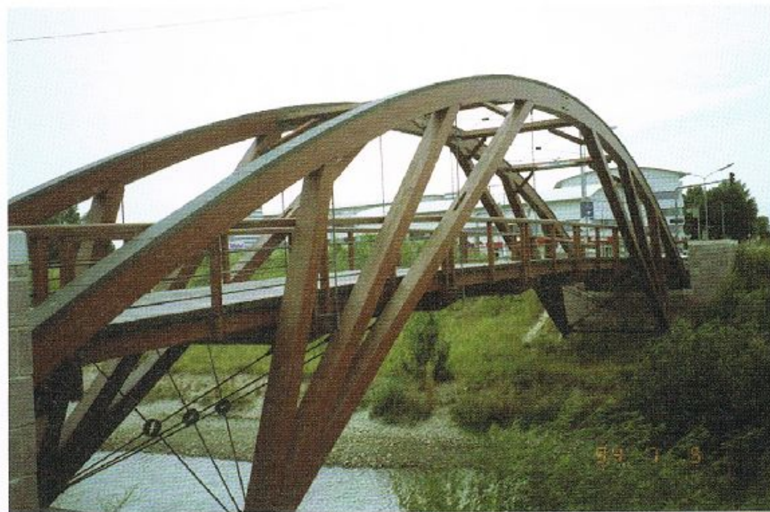
写真 5.1.2-15 マルヒフェルト運河橋(ウィーン市, 著者撮影)
