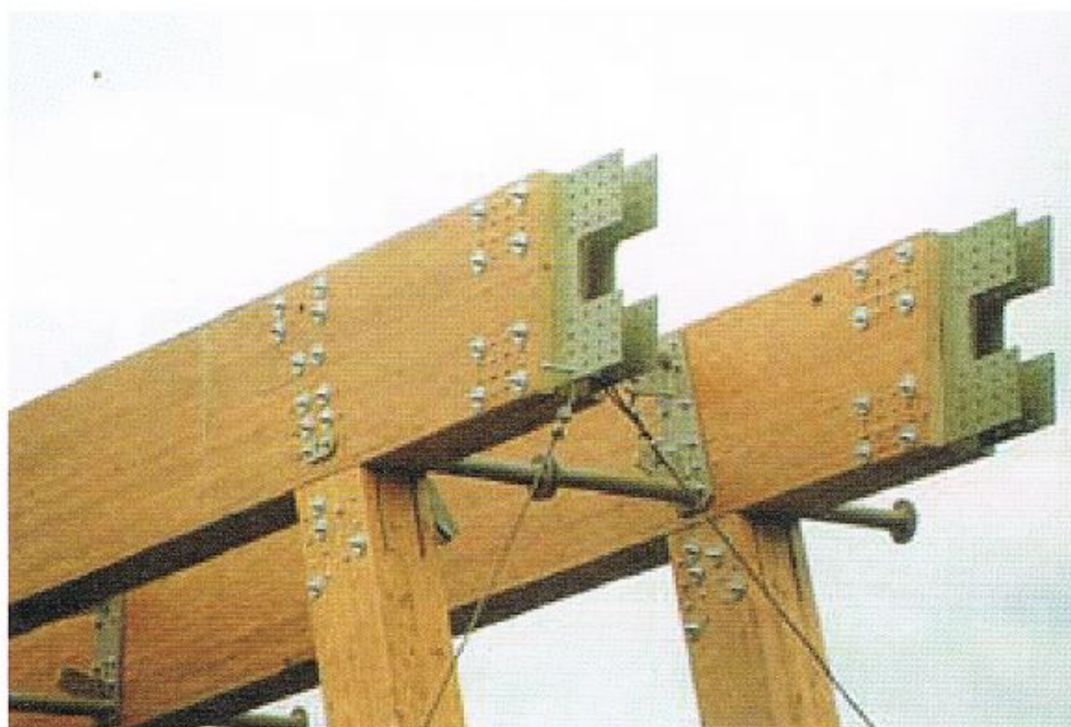
写真 5.1.2-12 主梁材の鋼板挿入型ボルト締め接合(ムール橋) (Firma Hubert Kulmer 提供)
