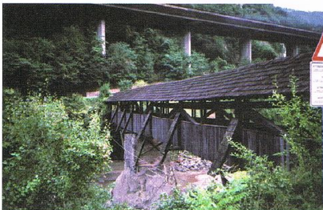
写真5.1.2-17 アイザック橋 (伊・ボルツァーノ, 著者撮影)
