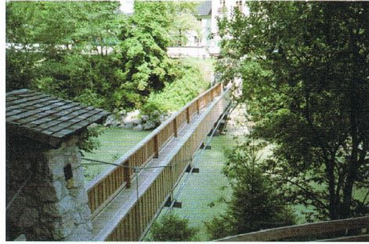
写真5.1.2-20 シグムント橋 (奥・クラムザッハ, 著者撮影)
