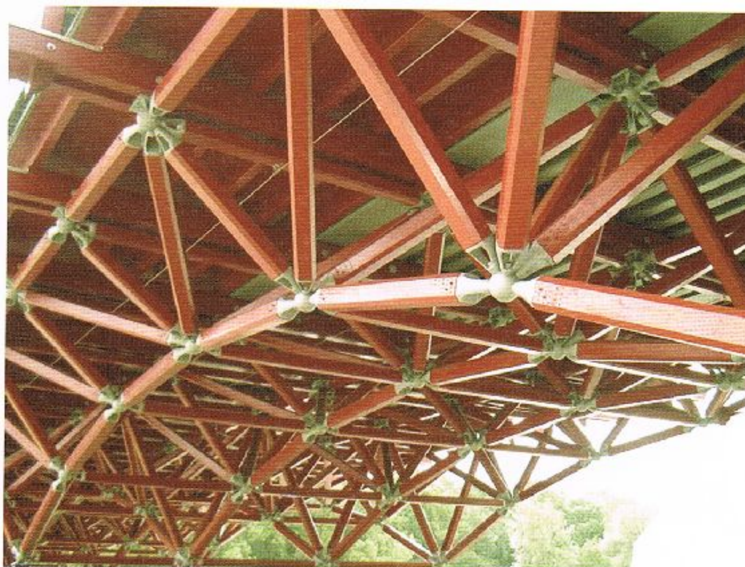
写真 5.1.2-6 立体トラスアーチ(タールキルヒェン橋, 著者撮影)
