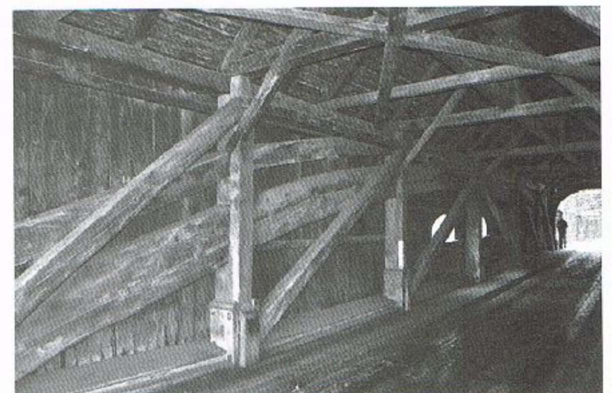
写真 5.1.1-5 グラット橋内部(著者撮影)
